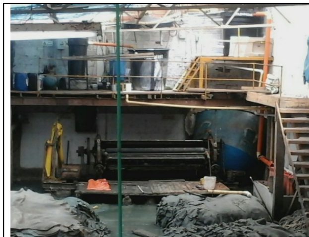
Foto No.3. Lugar del colapso de la unidad de tratamiento
